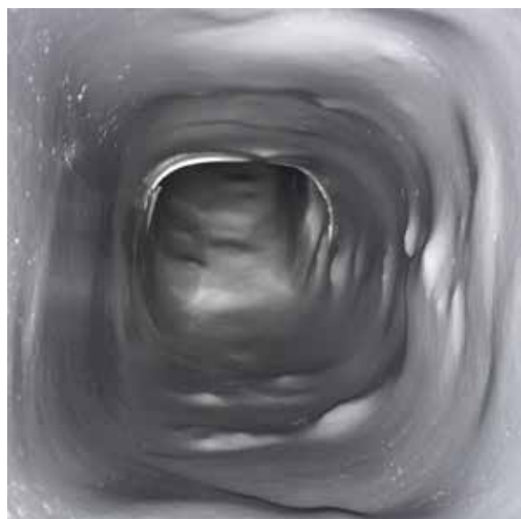
Tegelkanal efter tätning med Linervent
