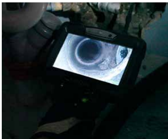
Granskning med inspektionskamera
