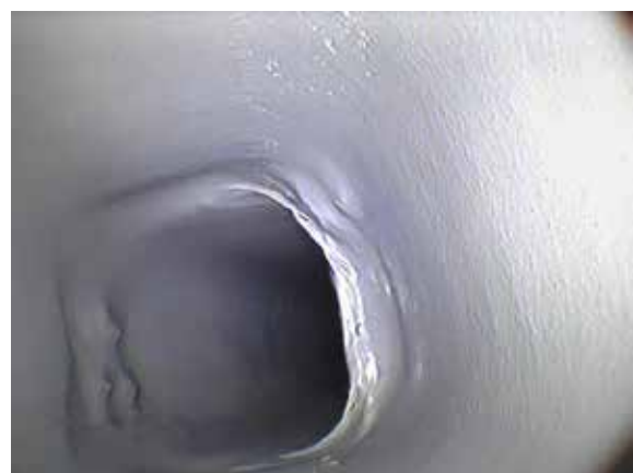
Eternitkanal efter tätning med Linervent
