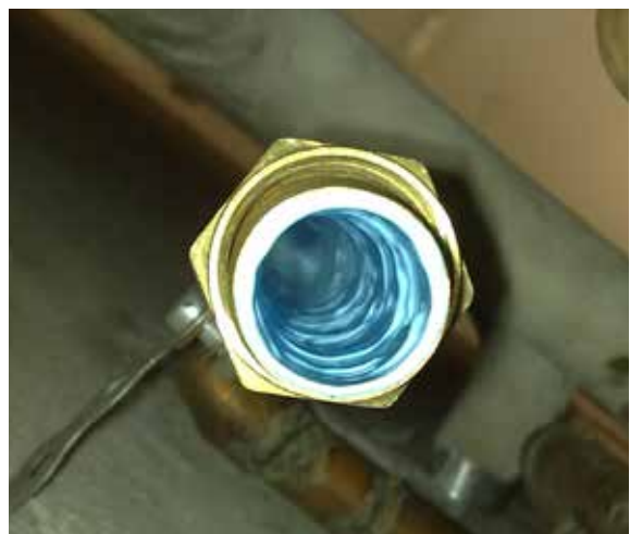
Ett kopparrör som rustats upp med relining.
