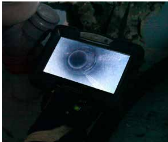
Inspektion av vattenrör med fiberoptikkamera.
