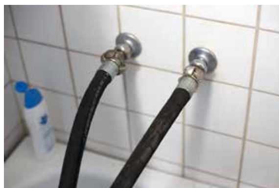
Badrum under relining; tryckslangar på bortkopplad badkarsblandare.
