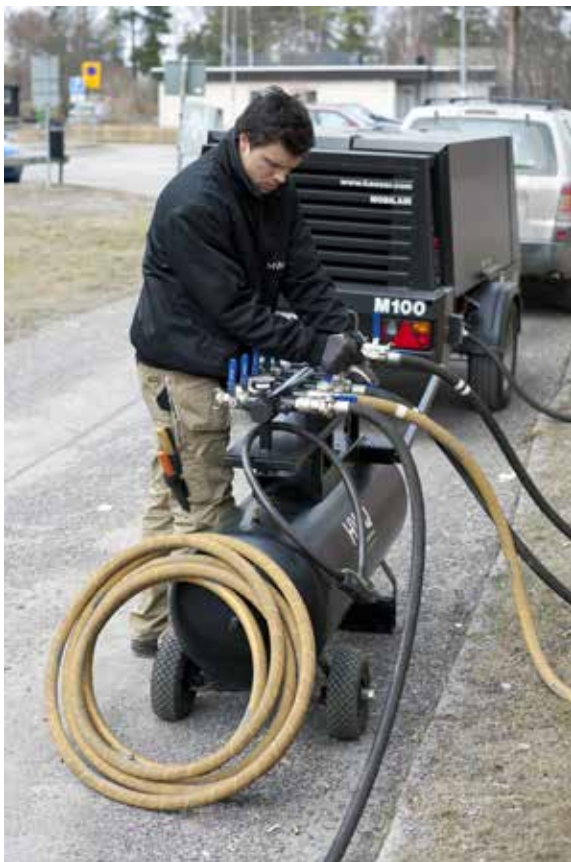
Reliningen utförs med maskiner och mjukvara speciellt utvecklade och anpassade för PermaProtectmetoden.
